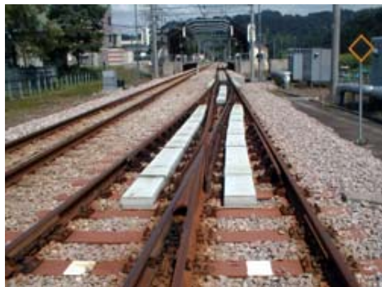
通常のポイントのクロッシング部分 (レールの切れ目が避けられない)
