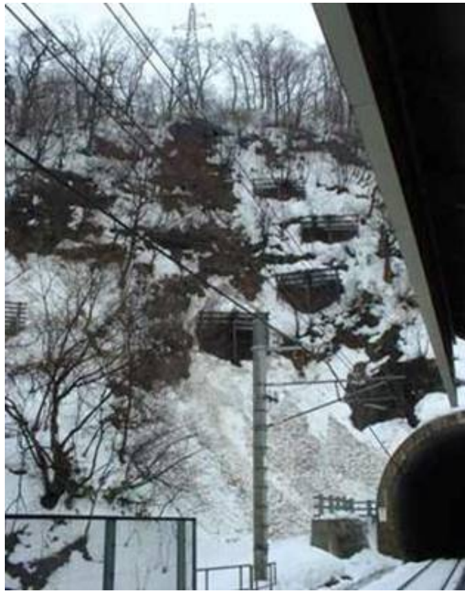
鍋立山トンネル大島口に設置されたスノーシェルター (ほくほく大島駅ホームから撮影)
