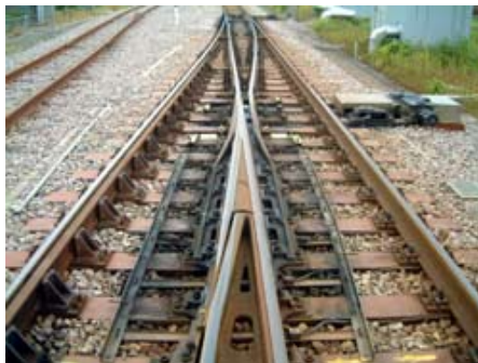
ノーズ可動式ポイント (レールの切れ目がない)
