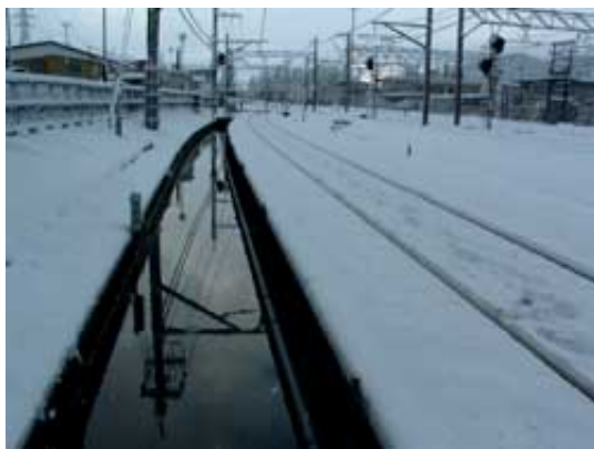
線路横の流雪溝(六日町構内)
