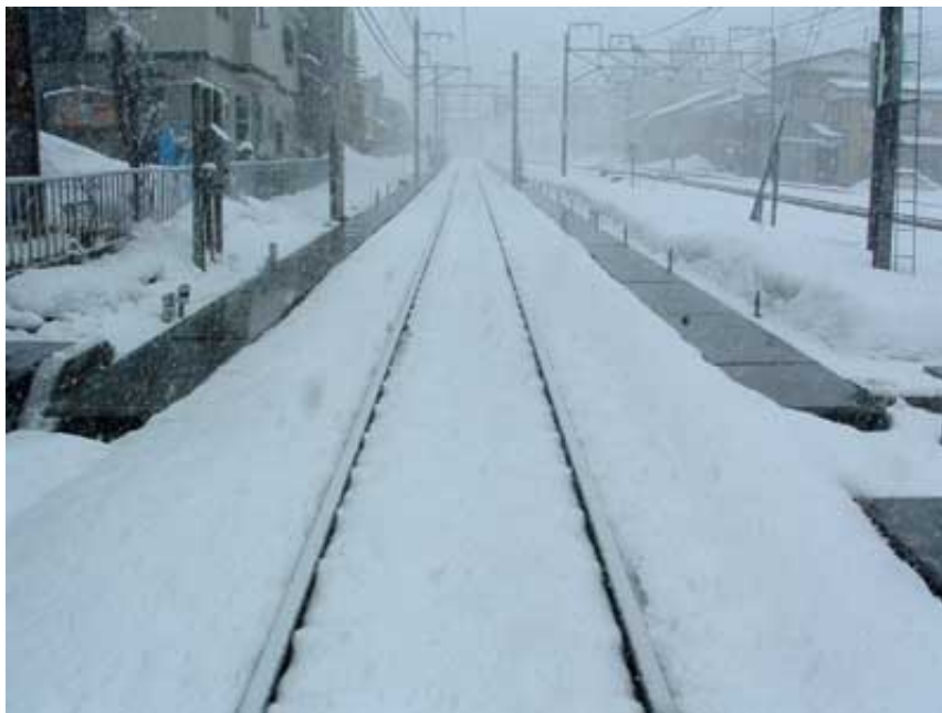
写真 ほくほく線の軌道両側に設置された消雪パネル。見事に融雪されています。
