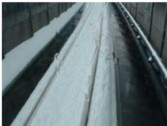
線路両側の流水溝(しんざ・十日町間)
