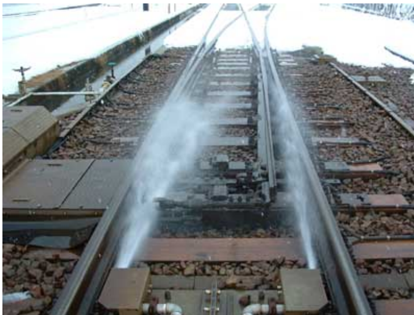
分岐器ジェット噴射装置の稼働状況 (ノーズ非可動の一般分岐器: 六日町構内)
