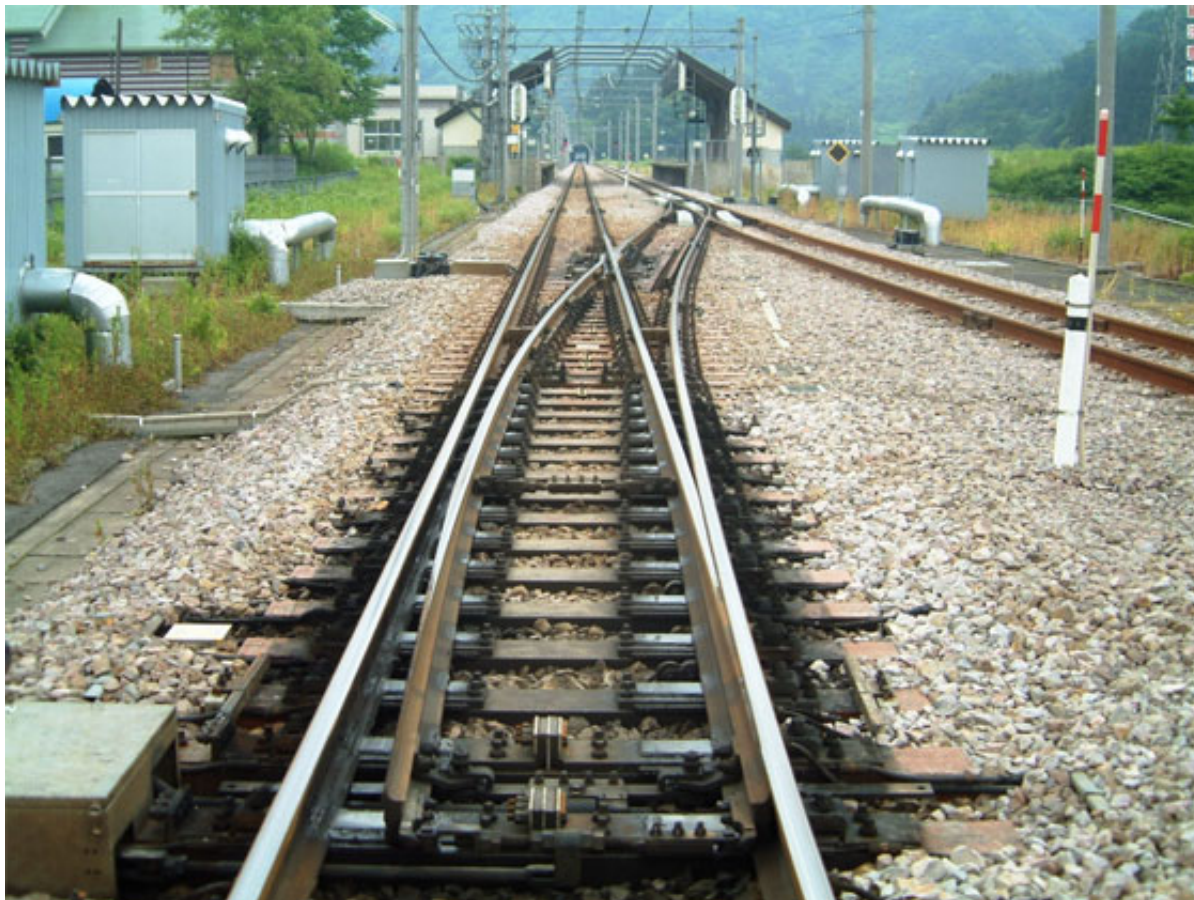
歪みのない軌道を確保することが重要な要素 まつだい駅構内バラスト軌道区間
