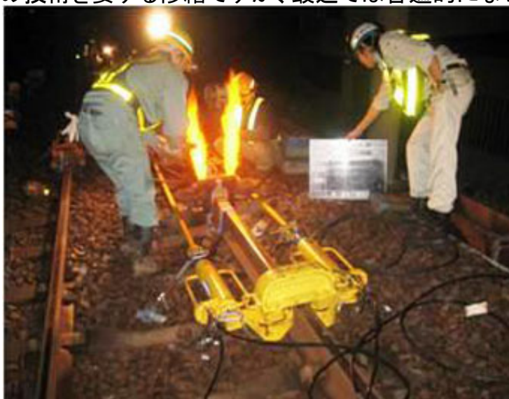
ロングレールの部分的取替作業
