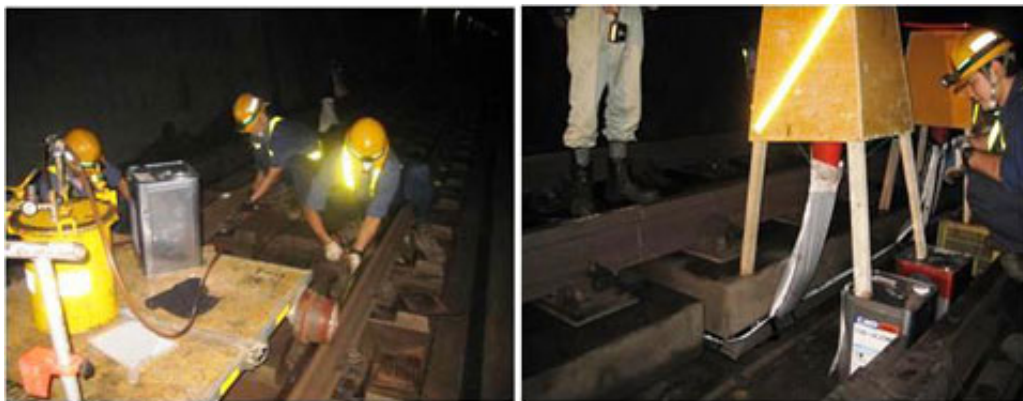
スラブ軌道の沈下対策工事（樹脂の注入作業）
