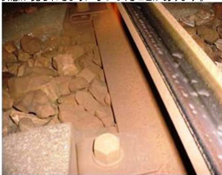
レール表面に発生する微細な傷
