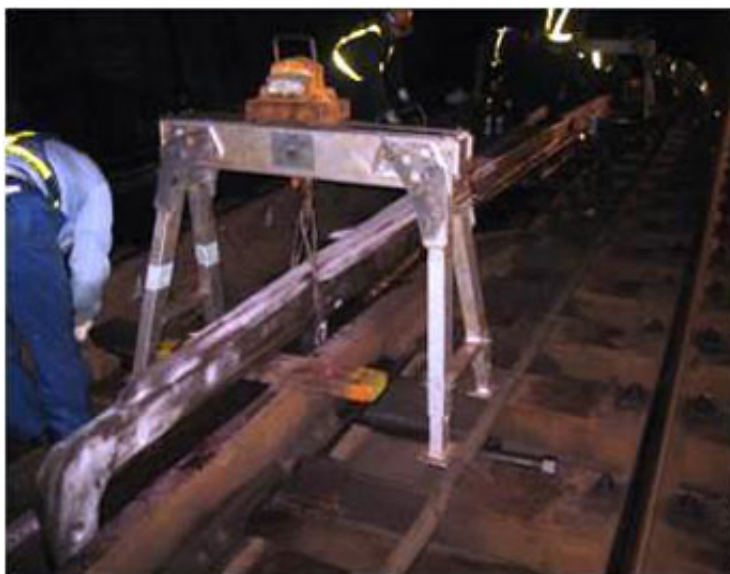
高速用分岐器(ノーズ可動クロッシング)の解体精密検査
